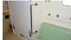
(24)乗降手すり(内側)
