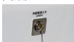
(20)100V電源引込装置(室外)*2
